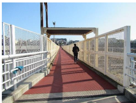
↑ 横浜国大方面に向かう跨線橋
