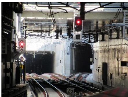
↑ 右のトンネルが J R 線方面 左のトンネルが東急線方面に連絡する
