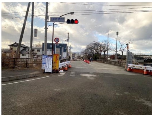
↑ 帰還困難区域内の国道6号線外の道路は原則立ち入ることが出来ない。
