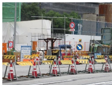
↑新しい出入口を建設中
