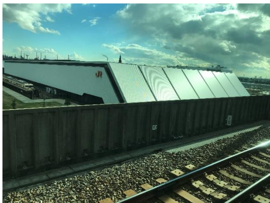
▲あおなみ線車内から外観を拝むことができる。
