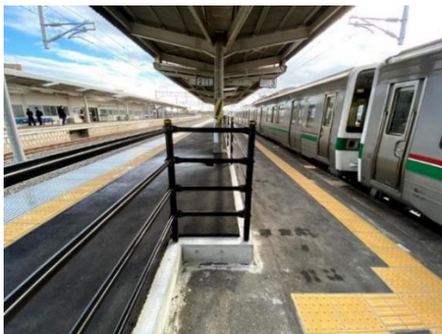
↑左:新ホーム 右:旧ホーム プラットフォームの高さが違うことがわかる
