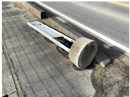
↑国道114号線沿いにあった倒れたままのバス停
