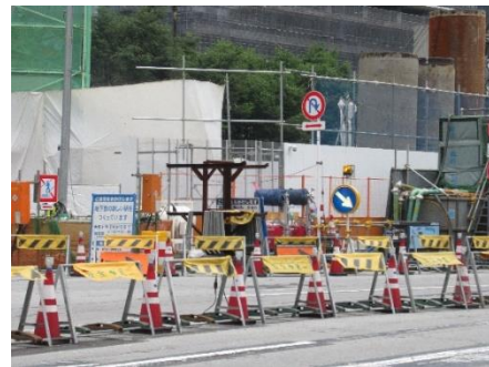
↑新しい出入口を建設中
