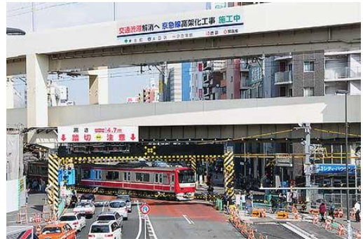
高架化工事中の京急蒲田駅周辺(railf.jp より)
