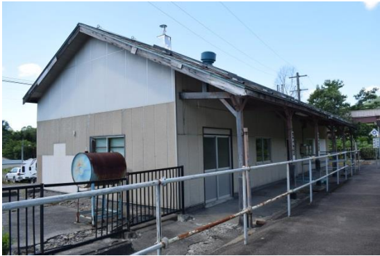
▲木造駅舎が残る鹿ノ谷駅
