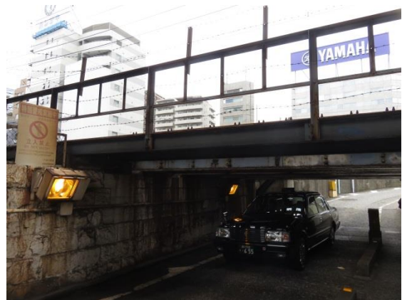
↑ガード下区間。すでにトラックは通れない
