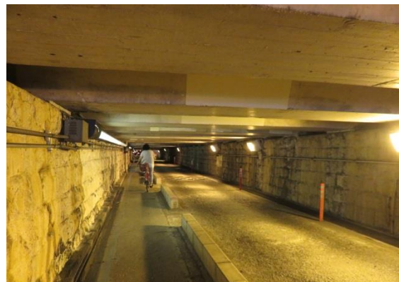
↑トンネルも初めのうちはまだ余裕がある
