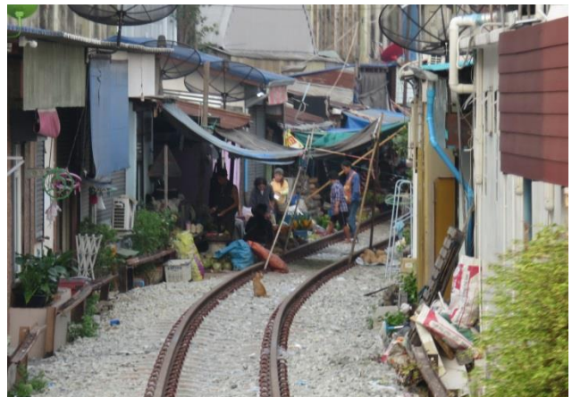
メークローン線の線路市場。屋根が張り出している
