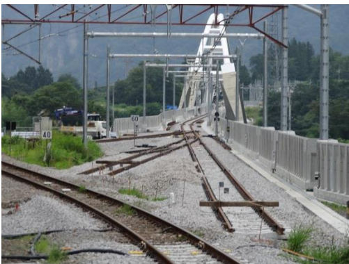
▲長野原草津口から新線の方を見ると、線路がギリギリまで設置されている。
