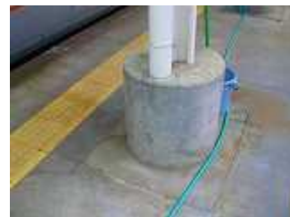
ホームかさ下げの名残 丸いコンクリートの高さが昔の ホームの高さ
