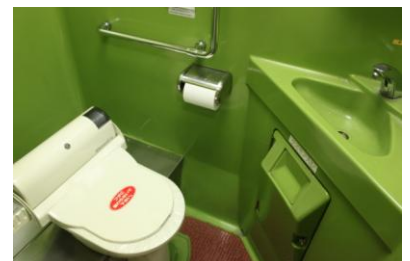
▲洋式トイレ。手洗いなど全てが集約される。
