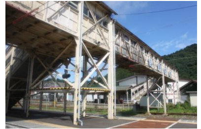
▲大鰐温泉駅跨線橋。
