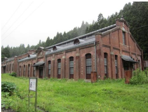
旧丸山変電所
