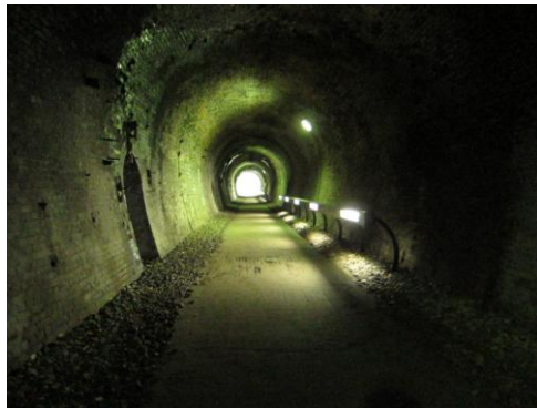
トンネル内部
