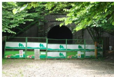
封鎖された第六号トンネル
