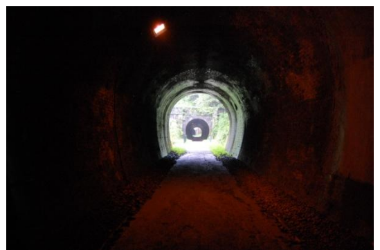
トンネル内部から
