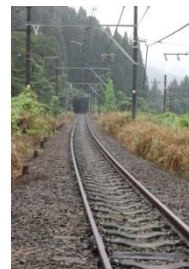
新線はそのままトンネルに入る
