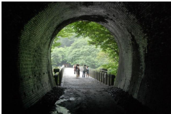
第五号トンネル出口
