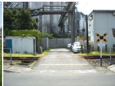
遮断機のない踏切
