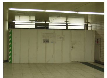
工事中の丸ノ内線連絡通路
