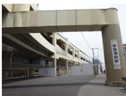
↑ 高架化された京急蒲田駅の外観
